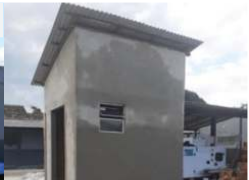
Estação de Tratamento – CRRCAP.
