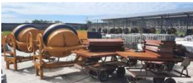
Foto: Betoneiras e carrinhos para transportes dos blocos
